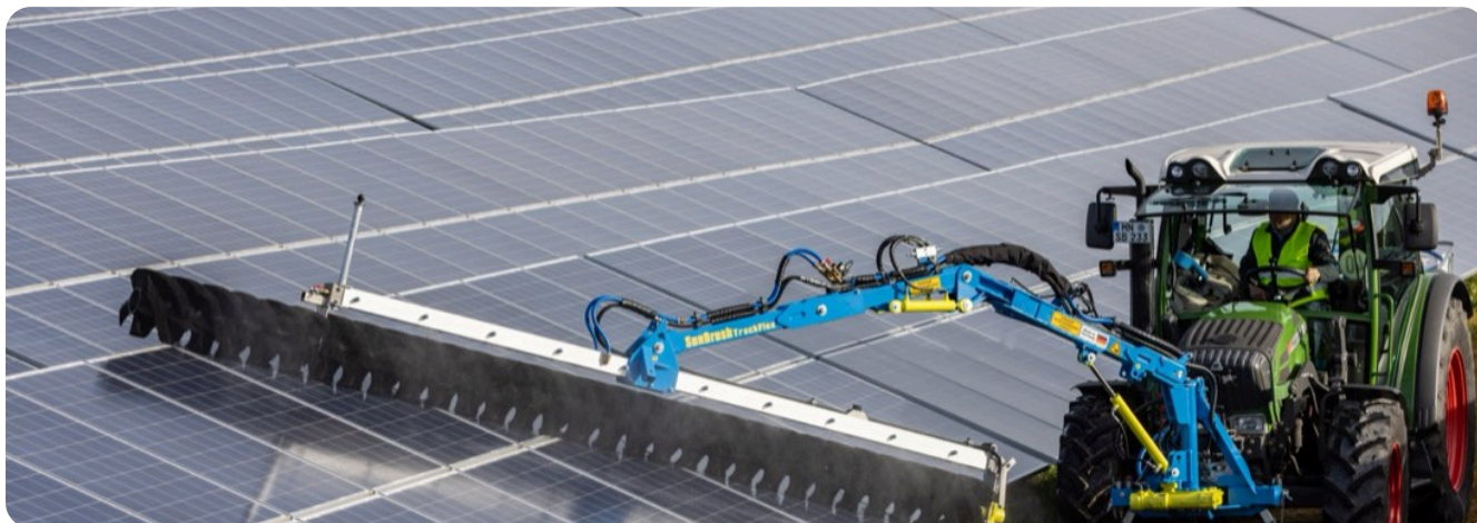
SunBrush® TrackFlex en operación: el cabezal mantiene presión uniforme sobre cada módulo mientras avanza.
